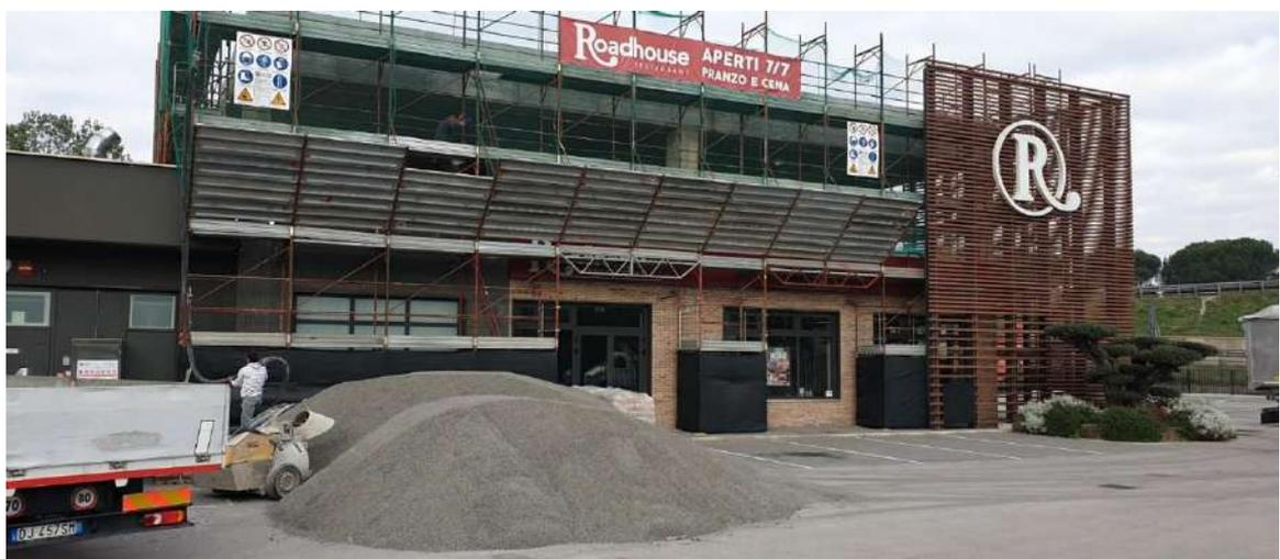
Isolamento termo-acustico di oltre **1.000 mq** tra coperture e sottofondi interni con spessore fino a 21 cm in **completa sostituzione dell'isolante leggero tradizionale**
