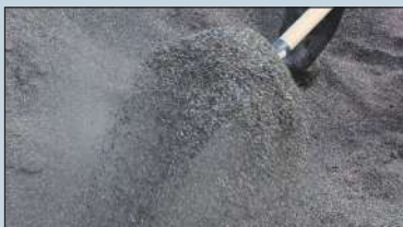
Posa sottofondo a secco G MIX GRANULAR
