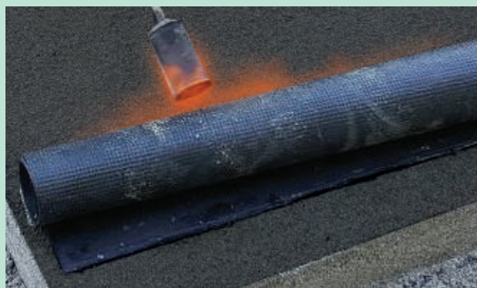
Saldatura guaina bituminosa su primer
