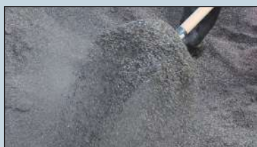
Posa sottofondo a secco G MIX GRANULAR
